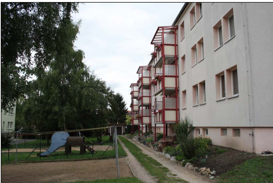
Hinteransicht von saniertem DDR-Wohnblock
