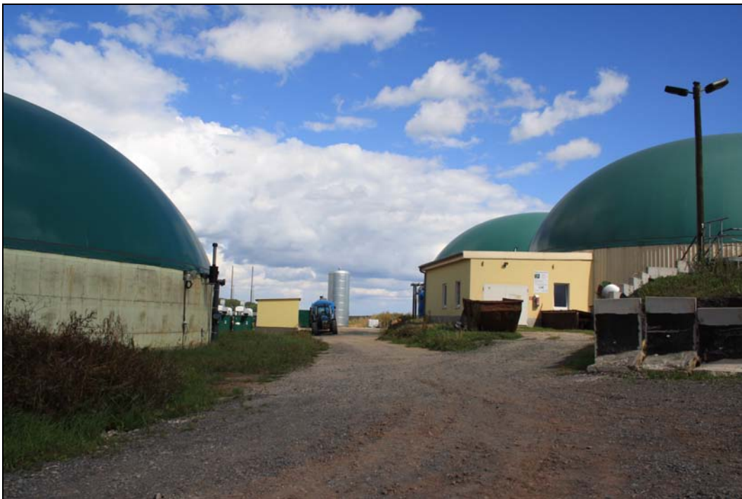
Anlage zur Nahwärmeversorgung in Göllnitz
