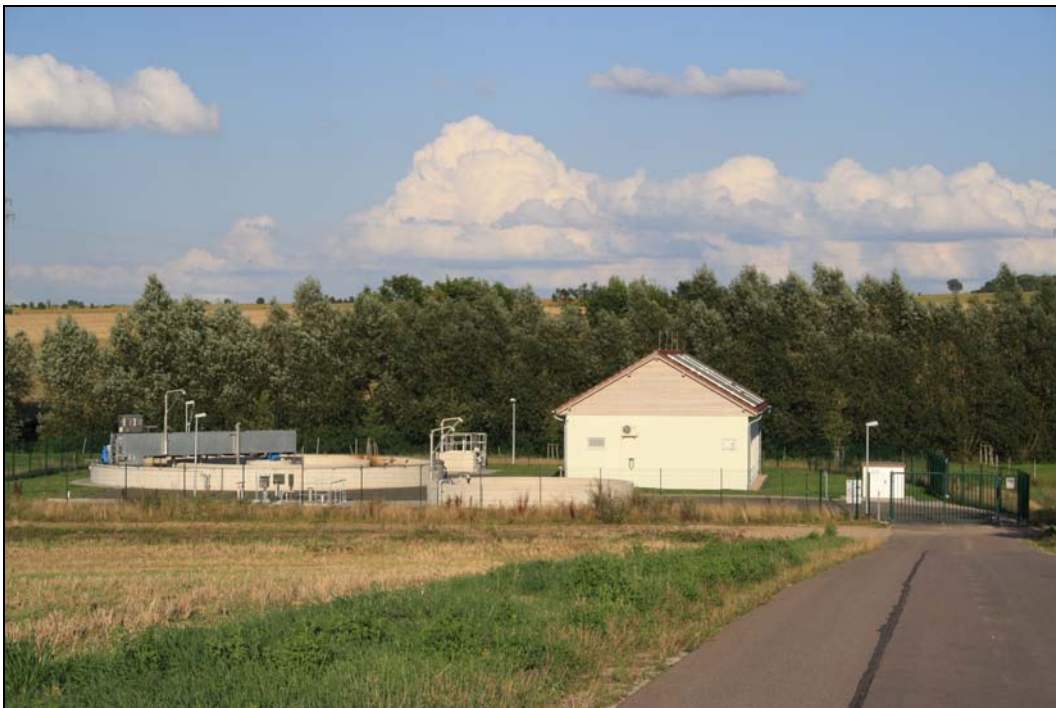
Kläranlage im OT Marlishausen
