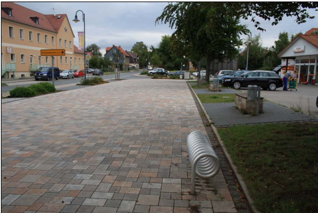
Straßenerneuerung/Erneuerung öffentlicher Plätze in Berlstedt
