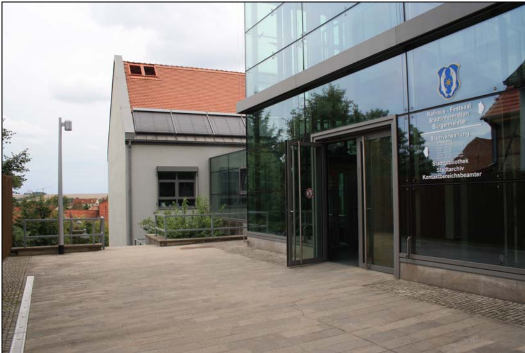
Neuer Anbau des Rathauses
