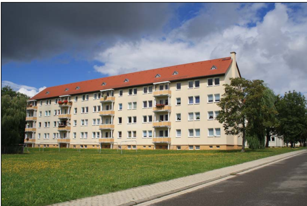
DDR-Wohnblöcke in Seelingstädt (Rückansicht eines Blockes)
