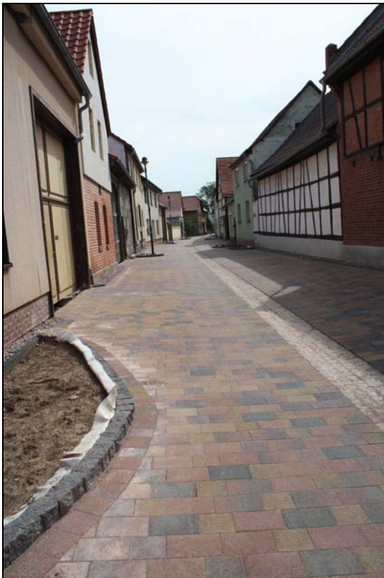
Straßenerneuerung in Andisleben
