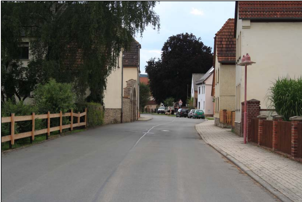
Erneuerte Straße mit Beleuchtung und Abwassersystem
