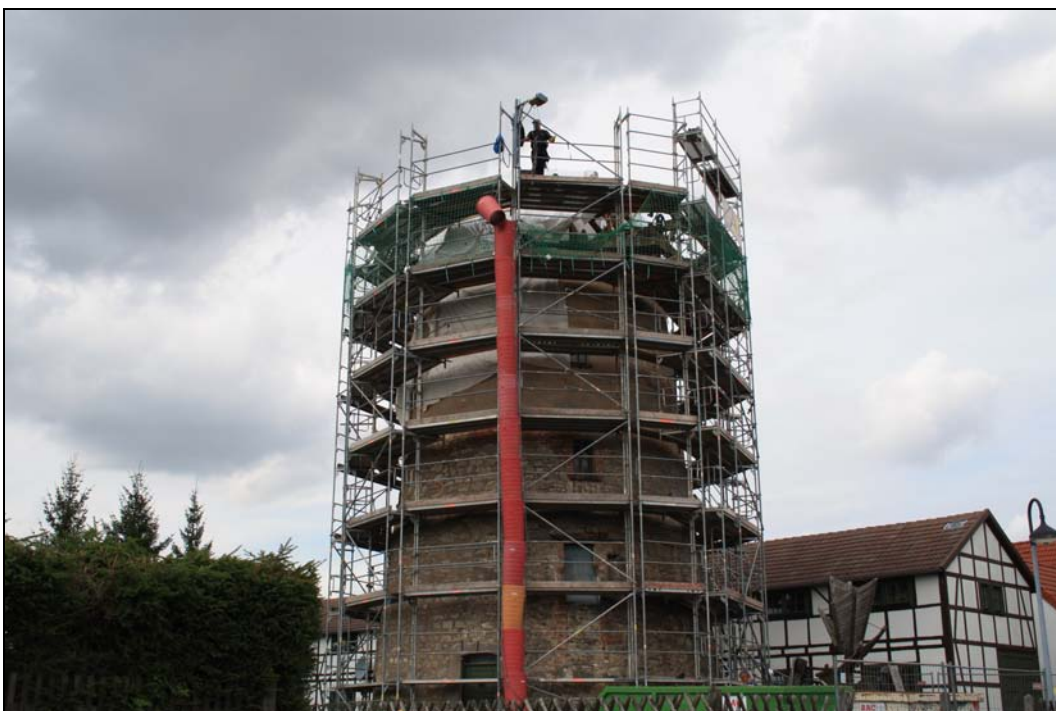
Mühlenkomplex, der gerade saniert wird
