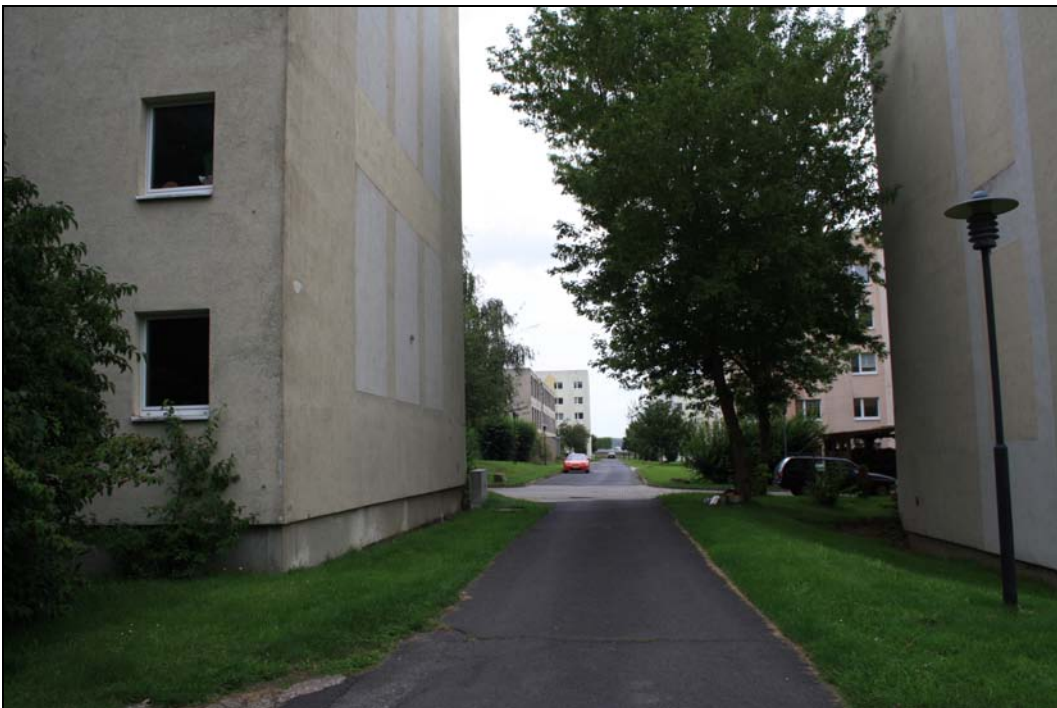
Sanierte DDR-Wohnblöcke (teilweise leerstehend) mit erneutem Sanierungsbedarf in Obermehler
