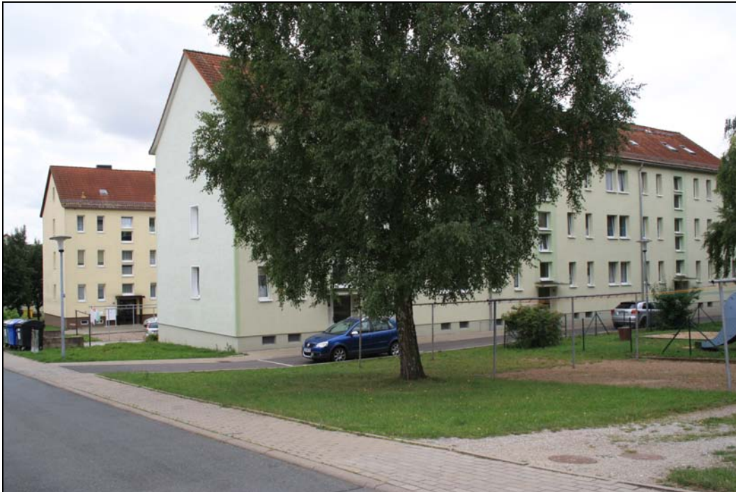
Sanierte DDR-Wohnblöcke mit Außenanlagen
