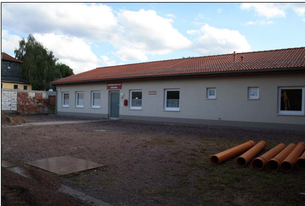
Neubau Feuerwehrgelände mit Außenanlage
