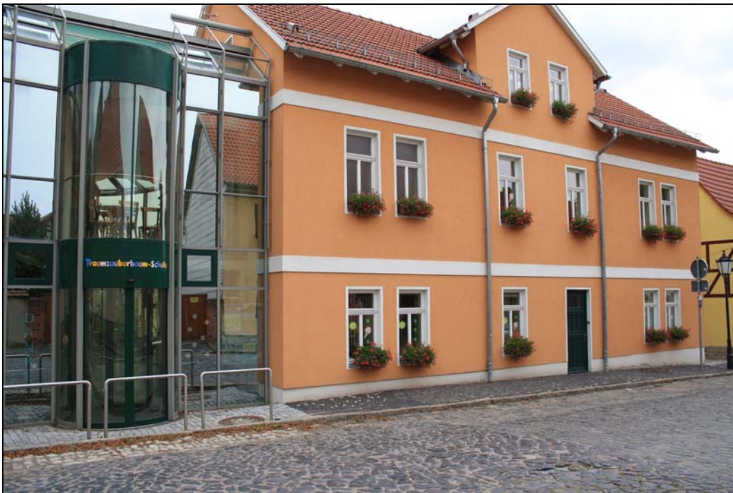
Vorderseite Grundschule „Traumzauberbaum“ (links: Neubau)
