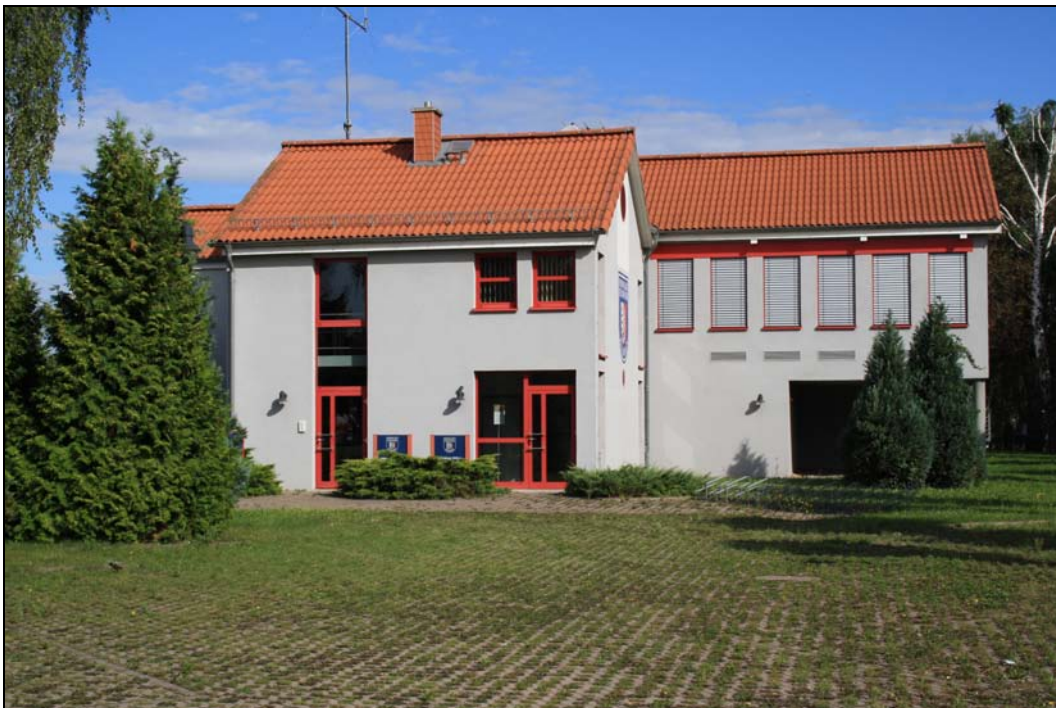
Neubau Feuerwehrgebäude mit Außenanlage
